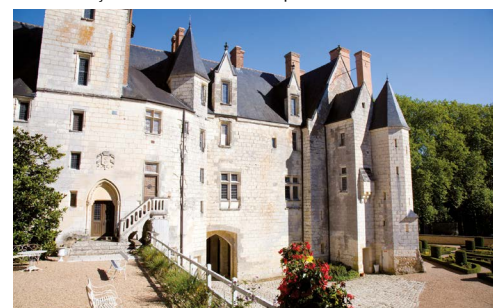
Vue de la façade ouest du château depuis la terrasse basse
