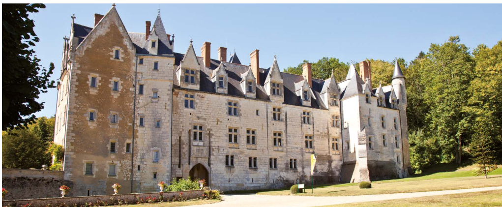
Vue d'ensemble de la façade depuis la basse-cour
